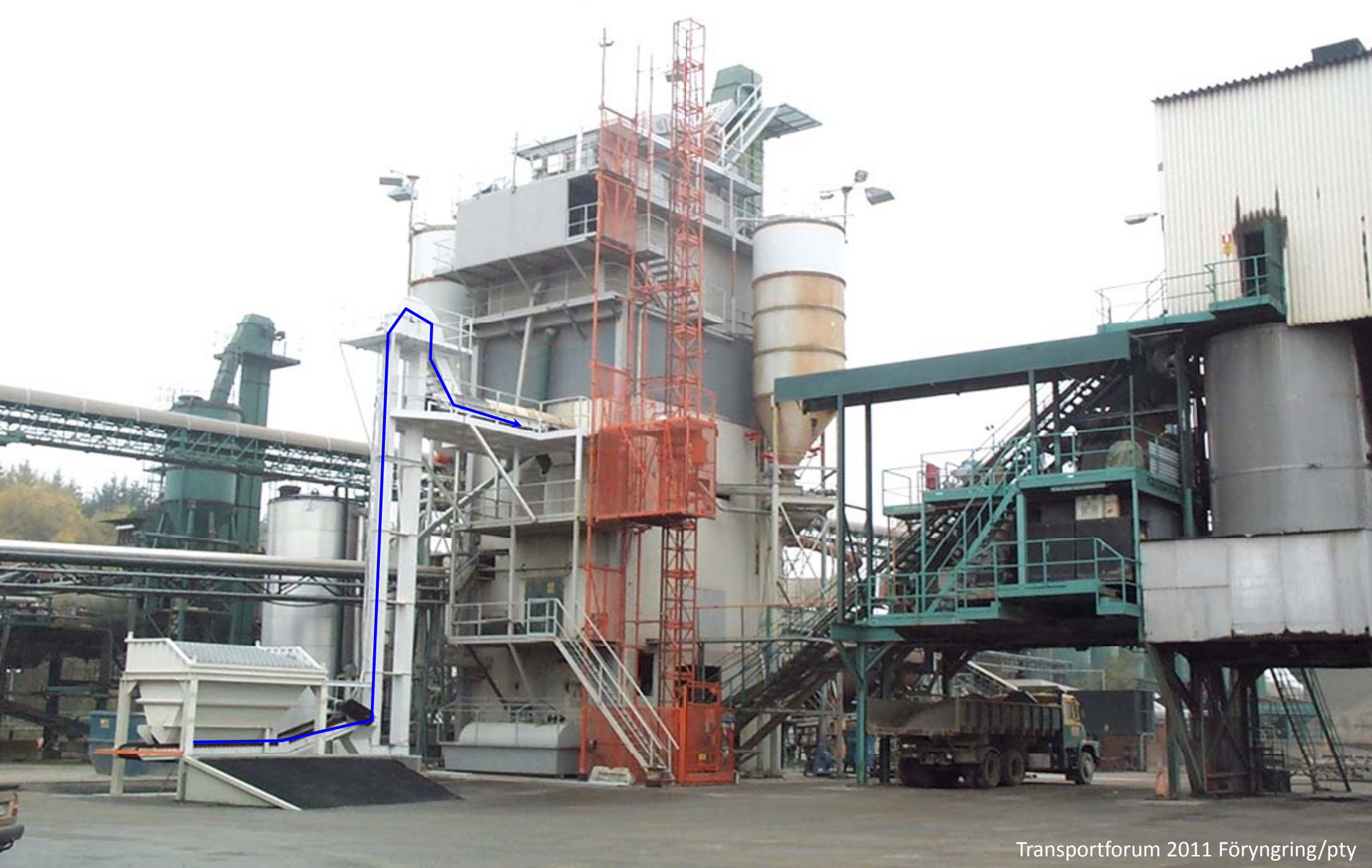
Dalbyverket med kalldosering för asfaltåtervinning.
